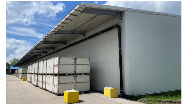
Beheizte Leichtbauhalle (ca. 2700 m 2 )
