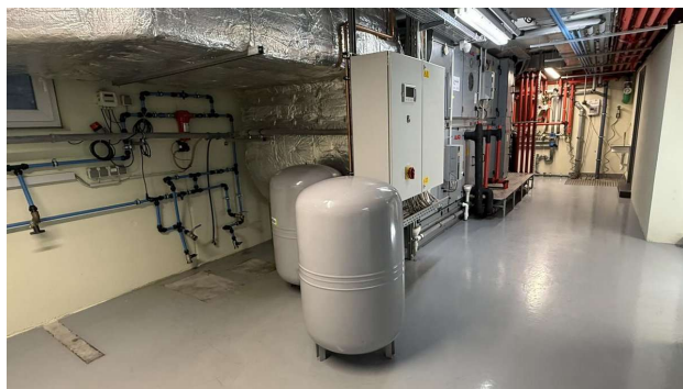
Keller 1 – ALKO-Präzisionslüftungsanlage
