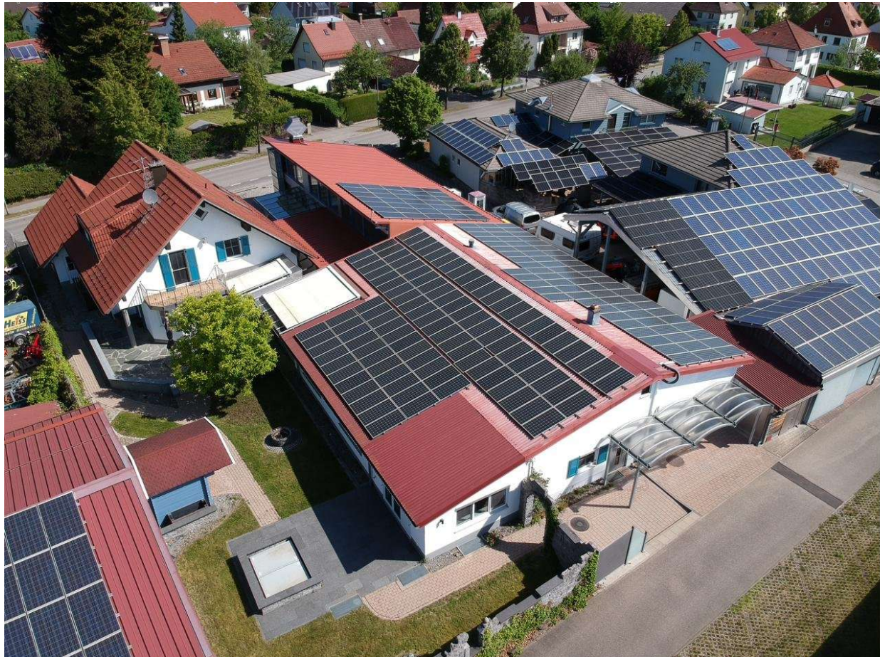
Luftaufnahme – Wohnhaus, Garten und Produktionshalle mit 38 kWp PV-Anlage
