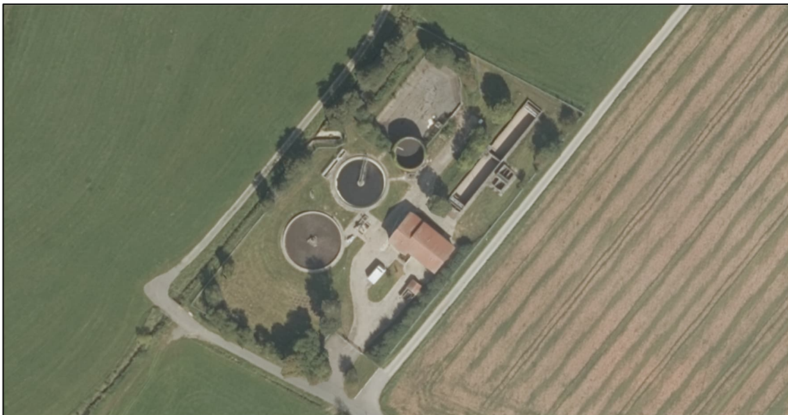
Abbildung 7: Luftbild Kommunale Kläranlage Irchenrieth (Fl.Nr. 486)
