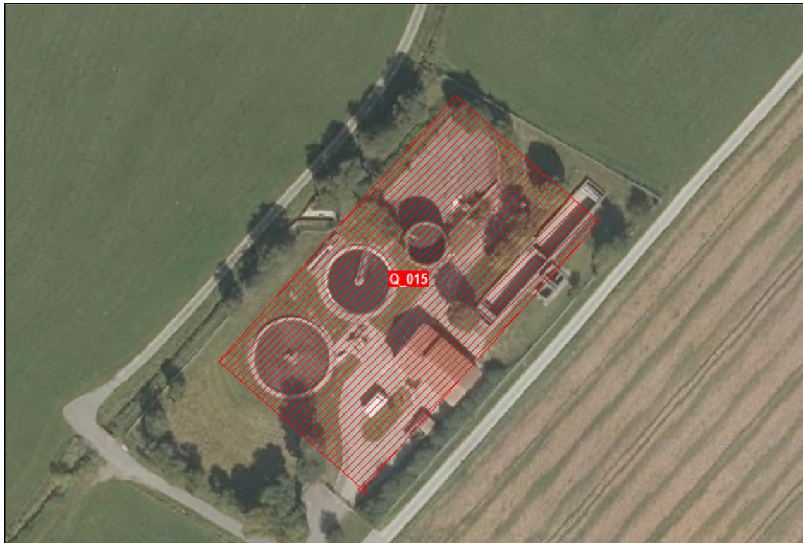
Abbildung 10: Luftbild mit Darstellung der Emissionsquelle (Kläranlage Irchenrieth)
