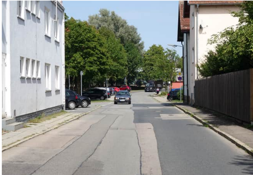
Bei der Neugestaltung von Straßenräume sollten neben der Beseitigung von baulichen Schäden sowie funktionalen und gestalterischen Mängeln auch Maßnahmen zur Verkehrsberuhigung, Barrierefreiheit und Klimaschutz in die Planungen einfließen.
