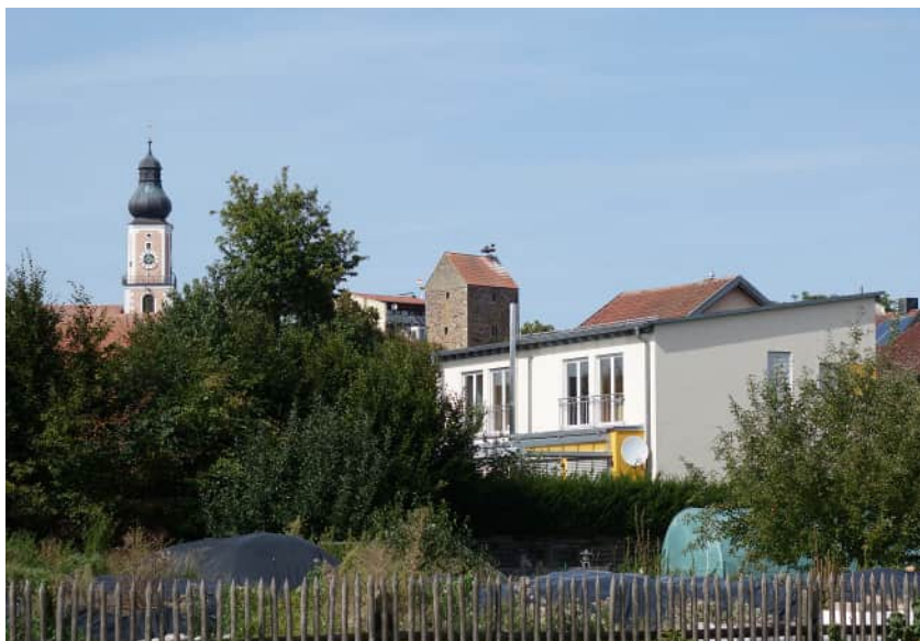
Attraktive Sichtbeziehungen zur Altstadt von Wohnlagen mit Freiraumbezug im Bereich Stadellohe
