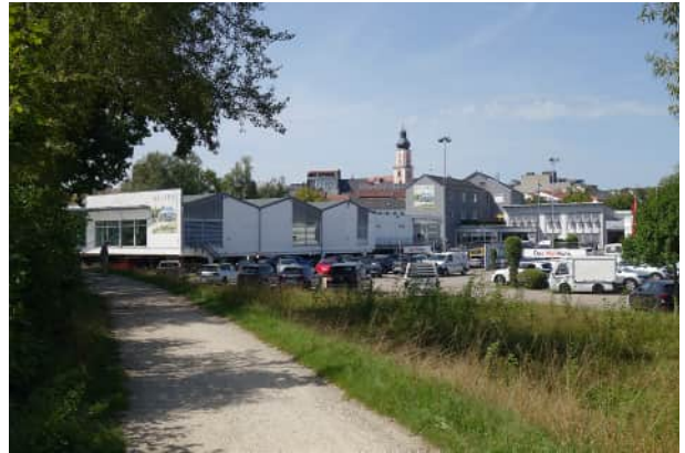
Langfristig ist auch für das Autohaus an der Fleischtorbrücke ein möglicher Transformationsprozess von Gewerbe zu Wohnen bzw. Renaturierung als Leitbild zu verfolgen.
