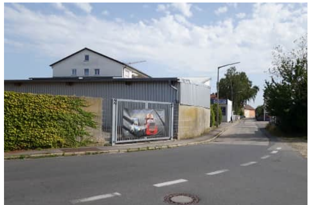
Die Baustruktur im Westen des Quartiers ist zu großen Teilen mit Anbauten, Abstell- und Lagerflächen durchsetzt, was insgesamt zu einem wenig ansprechenden Ortsbild führt.
