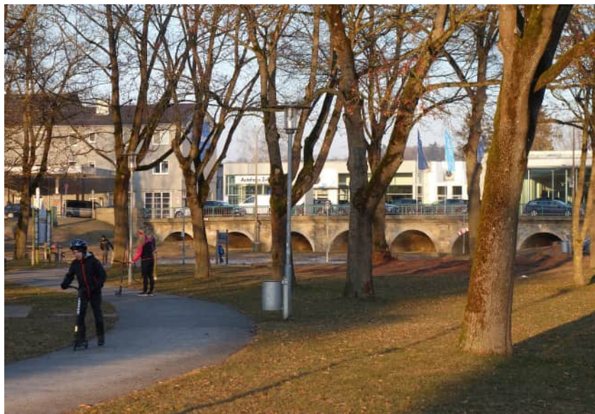
Nach Abriss und Neubau der Flutbrücke ist der landschaftlich besonders wertvolle Bereich am südlichen Regenufer wieder herzustellen.
