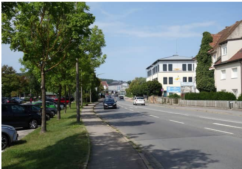
Die straßenbegleitenden Baumreihen an der Janahofer Straße vor Beginn der Baumaßnahmen. Nach deren Abschluss sollte wieder eine qualitätvolle Begrünung hergestellt werden.
