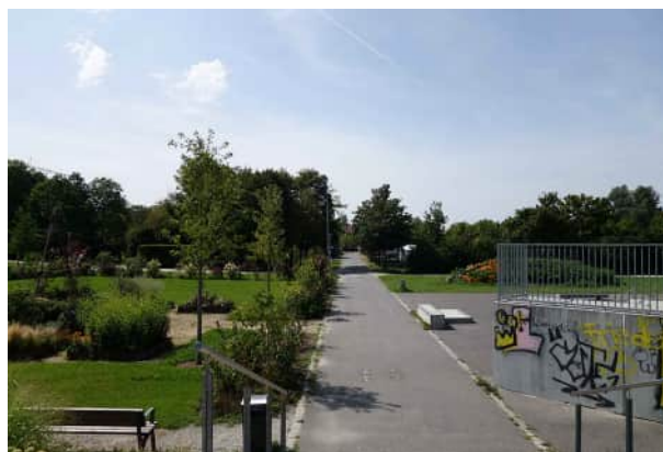
Die Wegeverbindungen des „Freizeitgeländes Quadfeldmühle“ sollen gepflegt, wo nötig saniert und mit dem Bereich Stadellohe besser vernetzt werden. Hierzu kann eine Stärkung des südlichen Zugangs zur Janahofer Straße beitragen.
