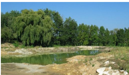
naturnahes Regenrückhaltebecken nordwestlich des Kreisverkehrs im Jahr der Herstellung 2008
