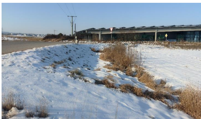
Böschung und Freileitung am Südrand, Blick nach Westen
