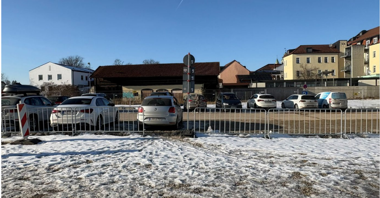
Abb. 3: Ansicht von Südosten – Baudenkmal mit dahinter liegender Bebauung (Foto Januar 2026 Jocham Kessler Kellhuber GmbH)
