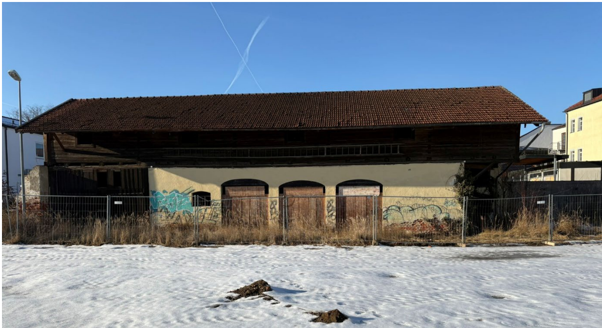
Abb. 22: Ansicht von Südosten – Ruderalfläche an der Längsseite des „Troadkastens“ (Foto Januar 2026 Jocham Kessler Kellhuber GmbH)
