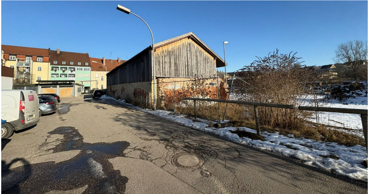
Abb. 20: Ansicht von Südwesten – Ruderalfläche an der Giebelseite des "Troadkastens" (Foto Januar 2026 Jocham Kessler Kellhuber GmbH)
