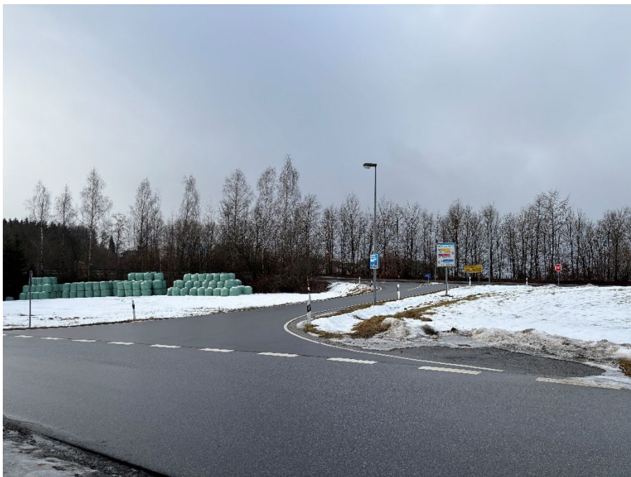
Abb. 4: Ansicht von Osten – Abfahrt von B11 auf Gemeindeverbindungsstraße; Foto Jocham Kessler Kellhuber (Januar 2025)
