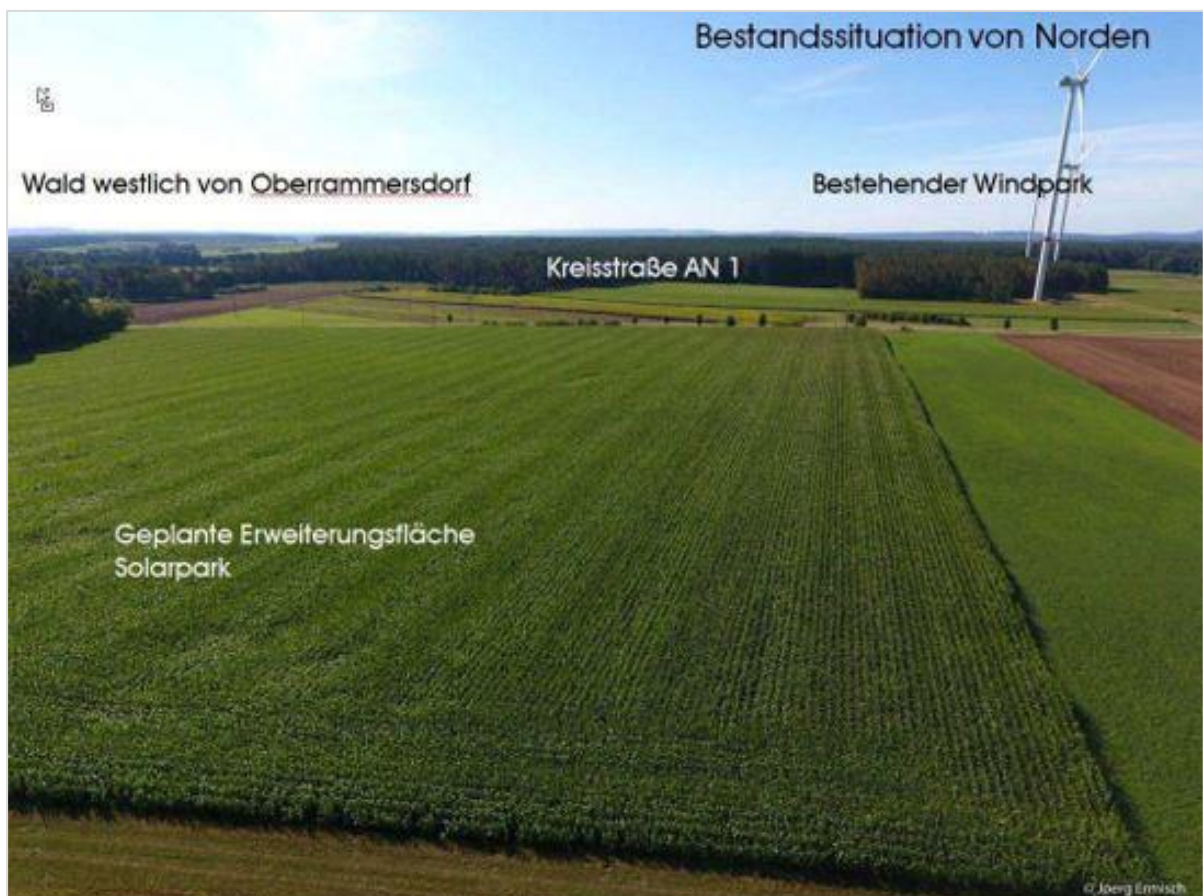
Abb. 5: Bestandssituation von Norden
