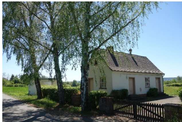
Ehemaliges Pumpenhaus und neue Trafostation
