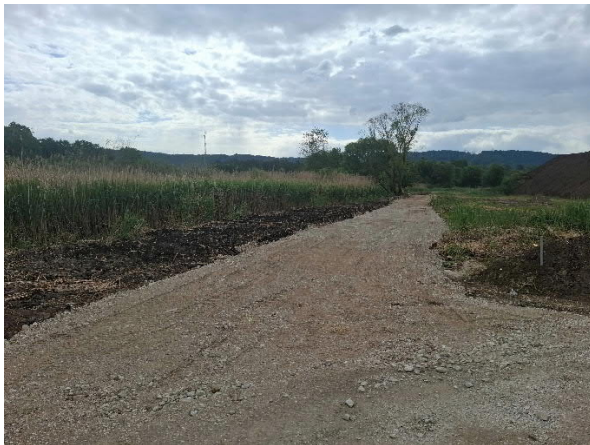
Überbaute Schilffläche durch Wegeneubau Mai 2025
