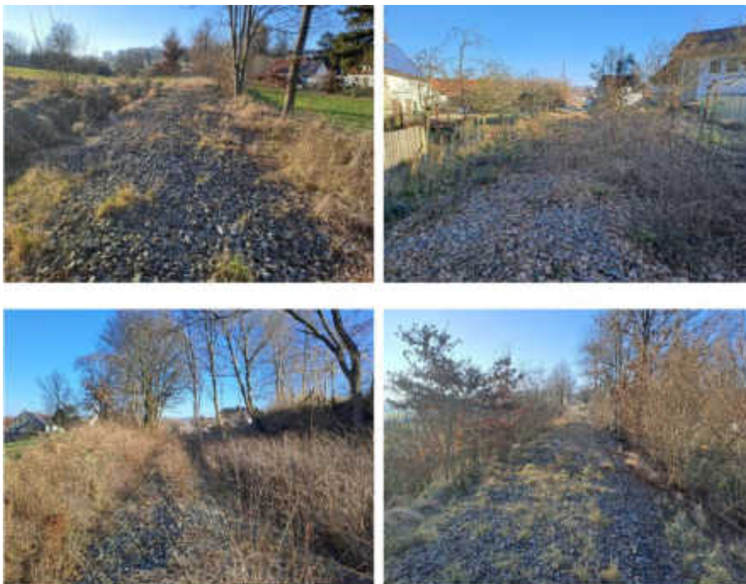
Abb. 4: Schotterflächen auf ehemaligem Bahndamm.
