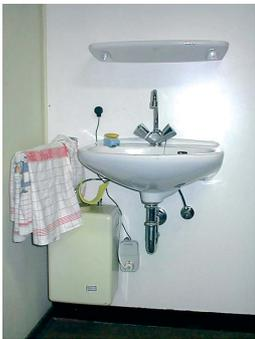
Bild 13: Anforderungsautomatik für 5 Liter-Untertischgeräte (Quelle: e&u energiebüro gmbh, Bielefeld)
