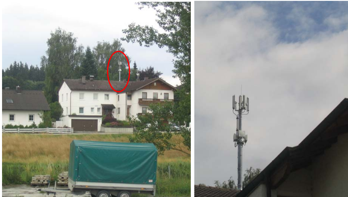
Bild 3.8 WiMAX-Standort "Bodenkirchen-Binastraße" von Messpunkt 9 aus gesehen (links); Detailansicht der Antennen (rechts)
