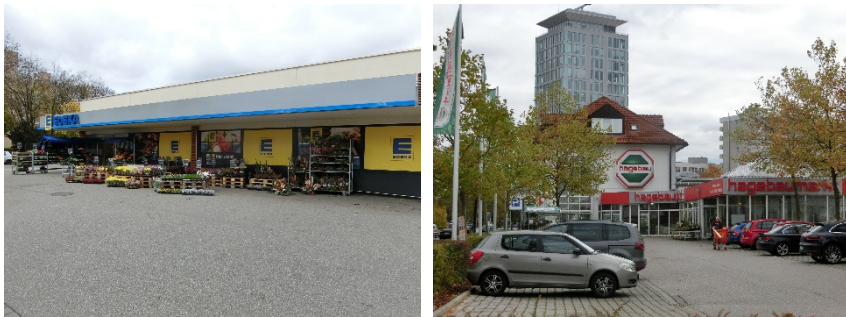
Abb. 17 Eindrücke Bereich „B 304/ Am Jagdfeld“
