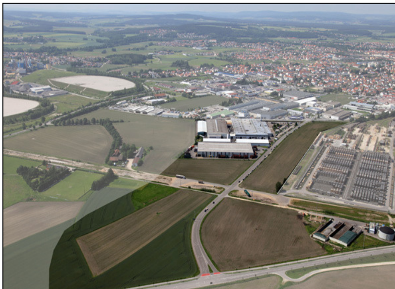
Blick von Süd nach Nord
