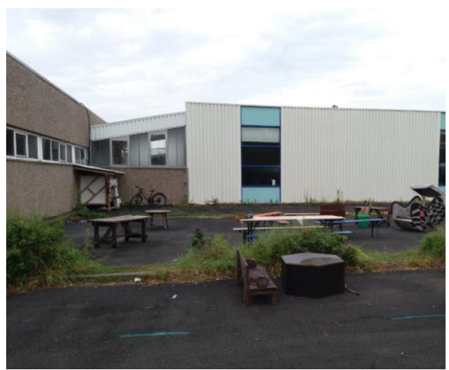
Abb.04: Aktuelle Ansichten des Grundstücks Ohmstraße 8
