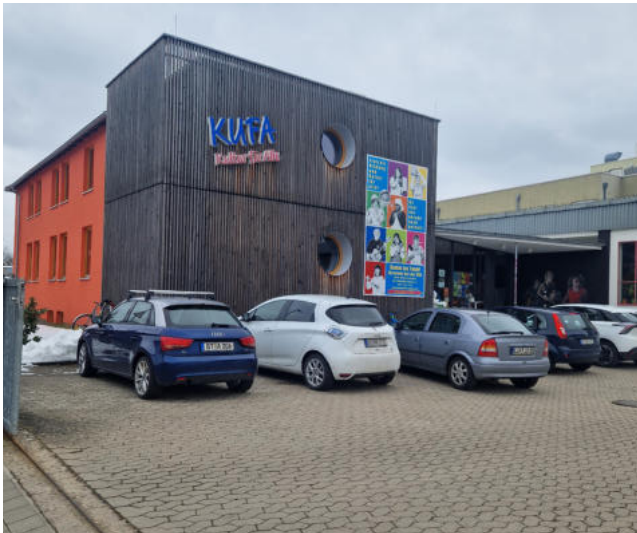
Abb.05: Kultureinrichtung westlich des Geländes
