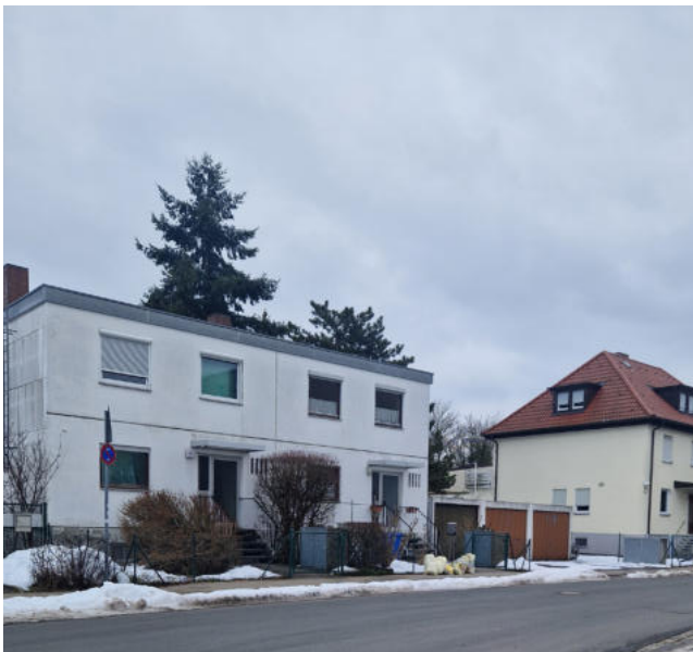
Abb.07: Wohngebäude westlich angrenzend an das Gelände
