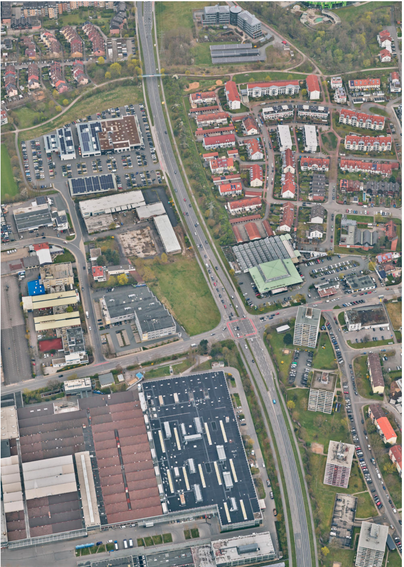
Abb.03: Nordblick über Grundstück und Umgebung
