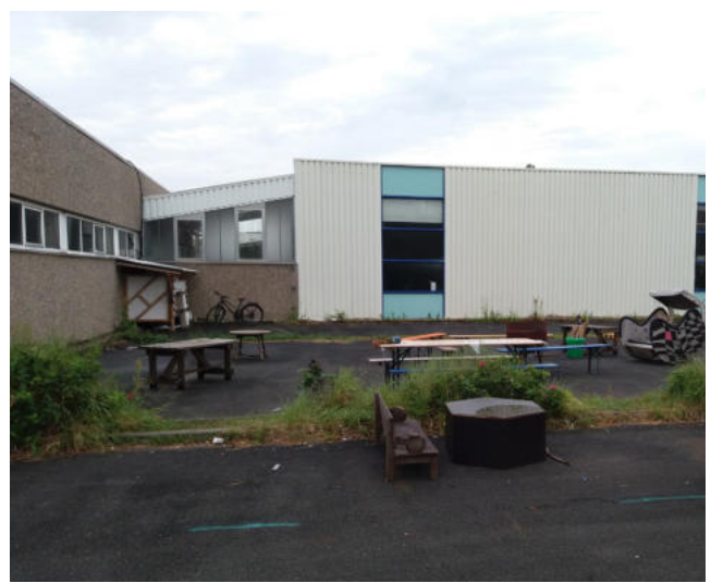
Abb.04: Aktuelle Ansichten des Grundstücks Ohmstraße 8
