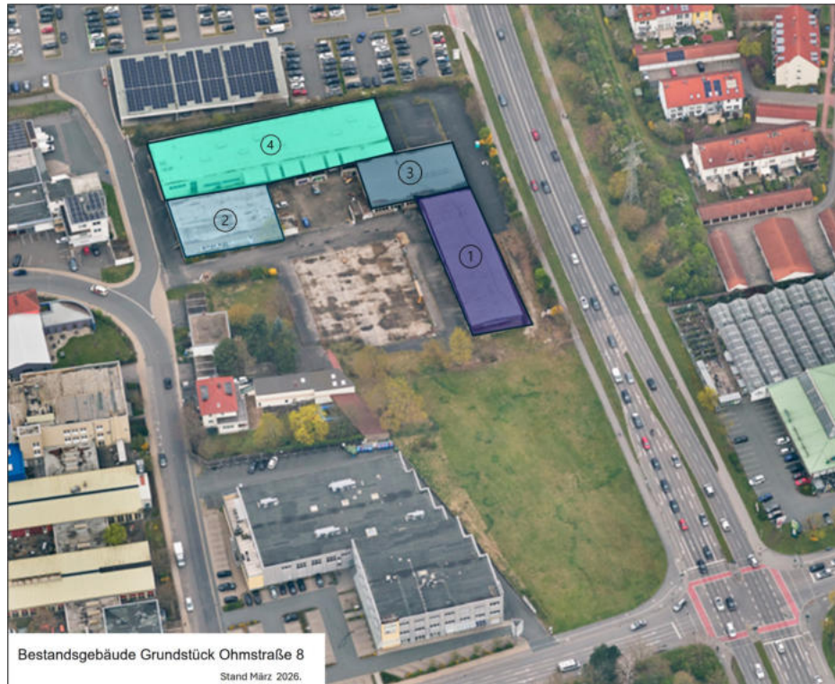
Abb.13: Luftaufnahme der Bestandsgebäude auf dem Grundstück
