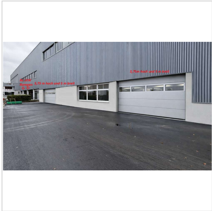
EG Halle Außenbereich bei zwei
