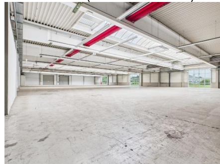
Halle 1a (Brandabschnitt 2)
