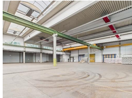
Halle 1b (Brandabschnitt 3)
