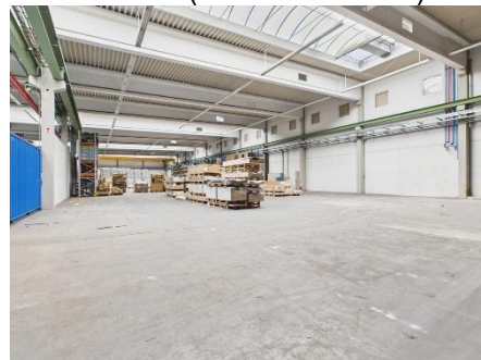
Halle 3b (Brandabschnitt 5)
