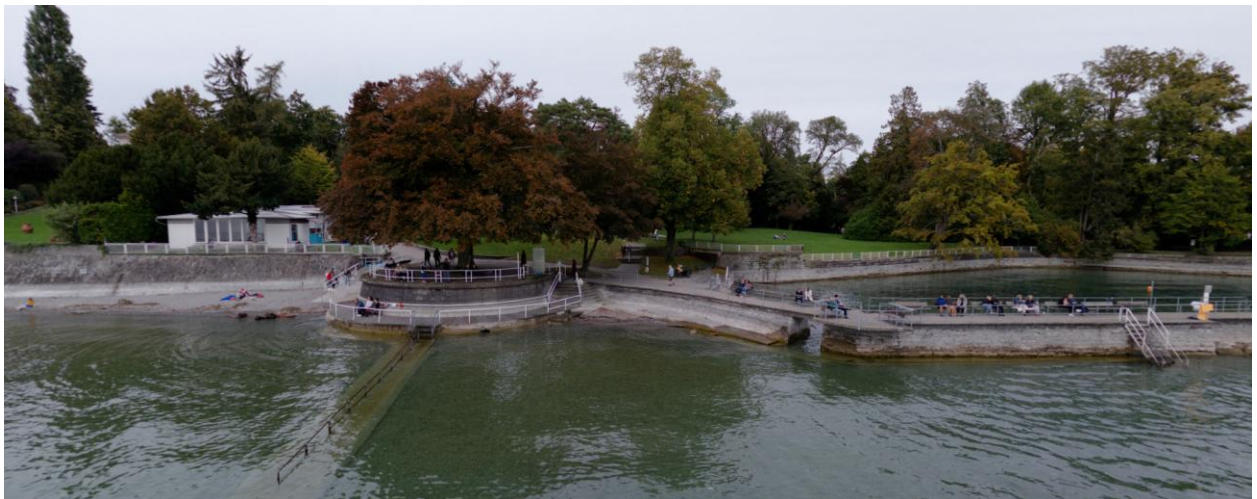
Abbildung 26: Blick vom Bodensee in Richtung Plangebiet (Quelle: Google Earth, © Gerhard Kastner)
