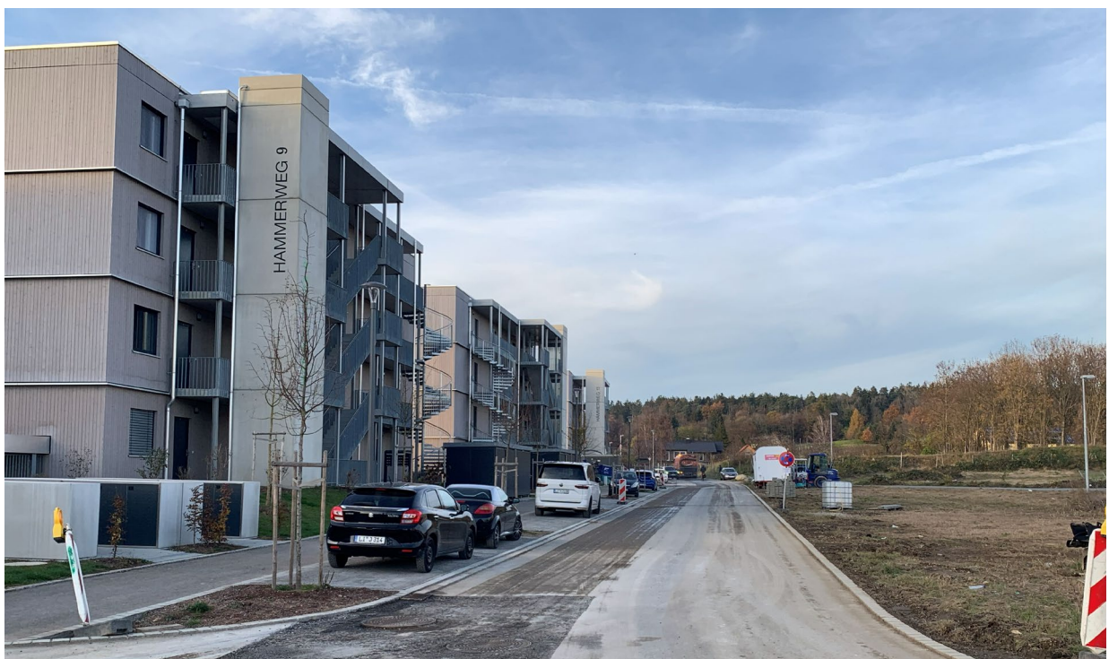
Abb. 7: Aktueller Ausbauzustand Hammerweg (Quelle:VI)
