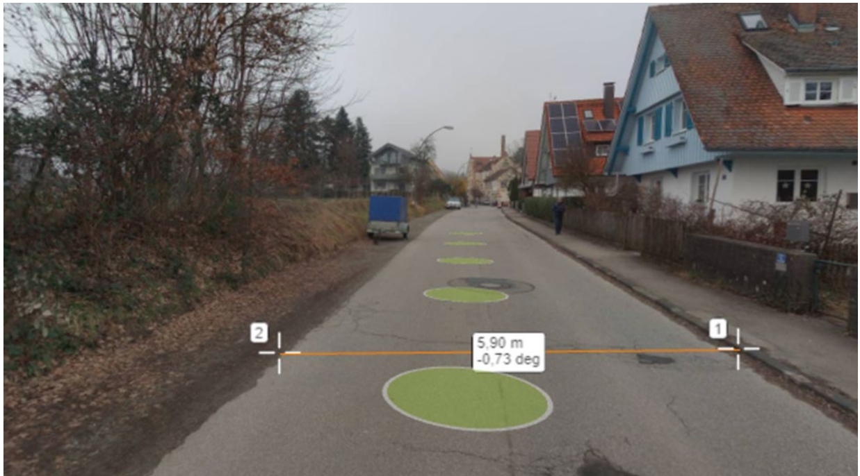
Abb. 8: Im Ausbaurzustand befindlicher Motzacher Weg (Quelle:Street Smart Lindau, 2024)
