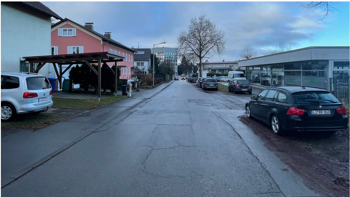
Abb. 4: Riggersweiler Weg (Quelle: i+R)
