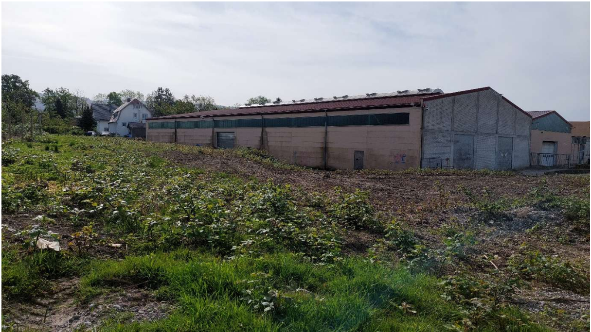
Abbildung 7: Größere Hallengebäude und anschließender Grünbereiche im Norden des Plangebiets (Aufnahme LARS consult)
