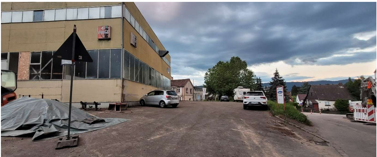
Abbildung 6: Betriebsgebäude und Freiflächenversiegelung im Süden des Plangebiets (Aufnahme LARS consult)
