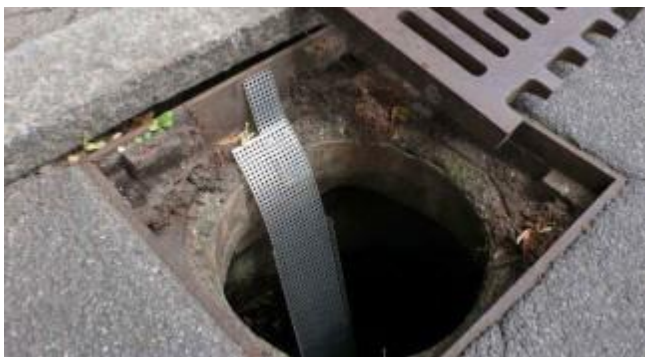
Abb. 5: Lochblech mit Aufstiegshilfe
