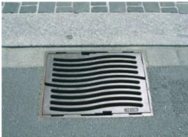
Abb.6: Engstrebiger Rost mit abgeschrägten Rand
