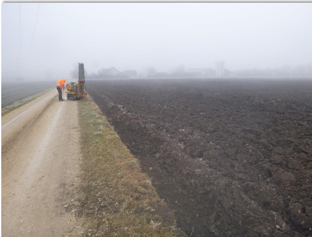
Bild: Baufläche am 20.01.2026, Blickrichtung Westen
