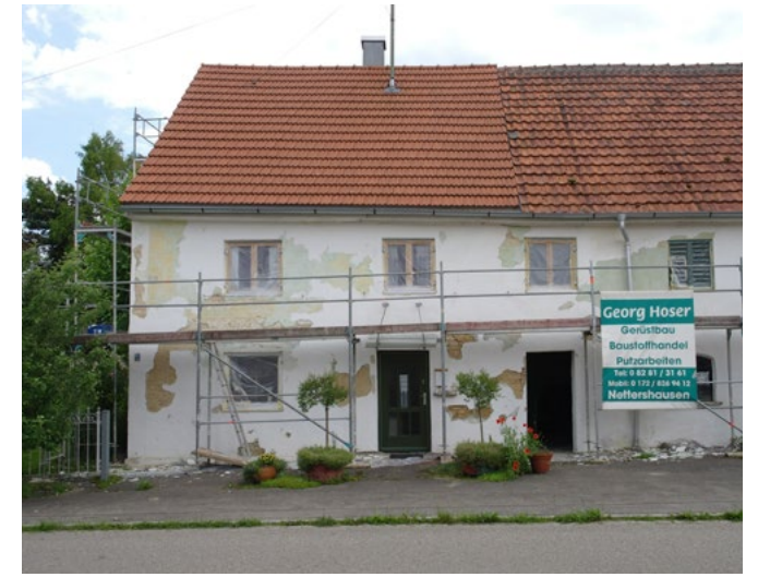
Abb. 029: Hof mit aktueller Sanierung
