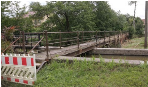
Abb. 105: Hochwasserschädigter Zusamsteg
