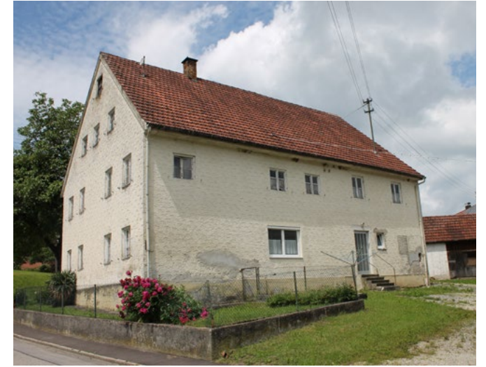
Abb. 045: Gebäude mit Sanierungsbedarf
