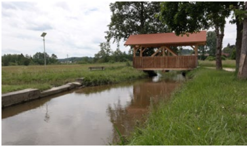
Abb. 083: Zusam mit Fußgängerbrücke
