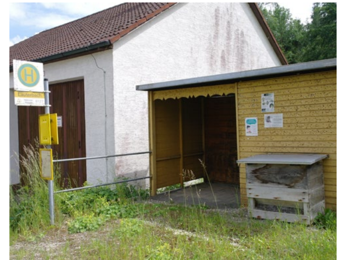
Abb. 062: Bushaltestelle mit Wartehäuschen
