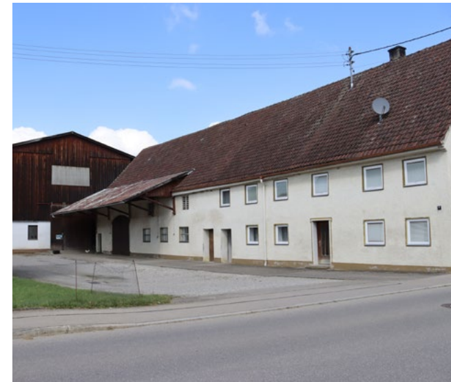
Abb. 153: Sanierungsbedarf in der Wackerlestraße
