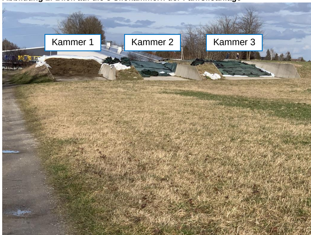
Abbildung 2: Blick auf die 3 Silokammern der Fahrsiloanlage
