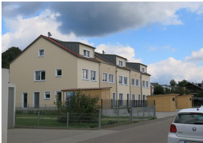
Abb. 12 Reihenhausbebauung Mauerbacherstraße, Quelle: PV München 09.2025
