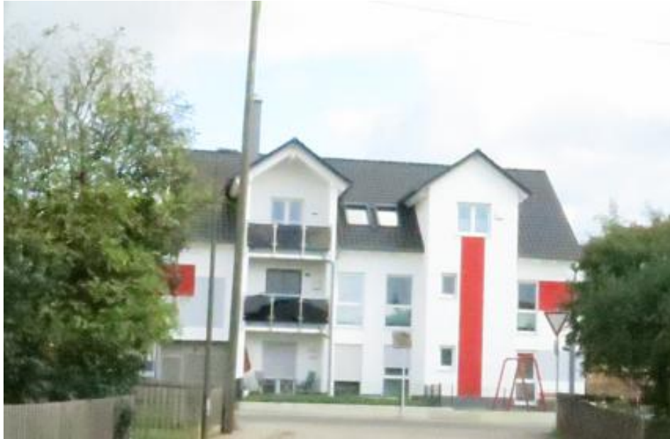
Abb. 8 Mehrfamilienhaus Fuggerstraße 9, Quelle: PV München 09.2025
