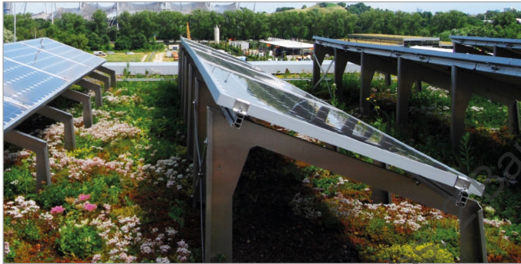
Solaranlage auf Gründach – beispielhafte Umsetzung (Freie Hansestadt Hamburg, Behörde für Umwelt und Energie (BUE), „Dachbegrünung Leitfaden zur Planung“, S. 28)
