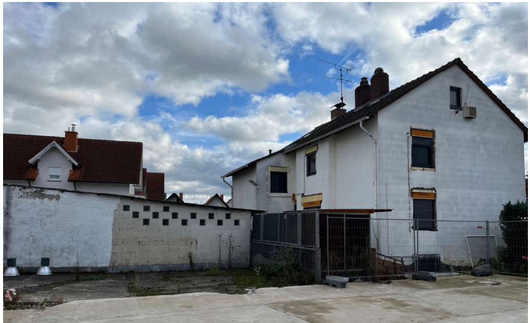
Osten des Geltungsbereichs – das Wohnhaus auf der Parzelle 368/1 mit den Nebengebäuden auf der für die Erschließung vorgesehenen Fläche.
