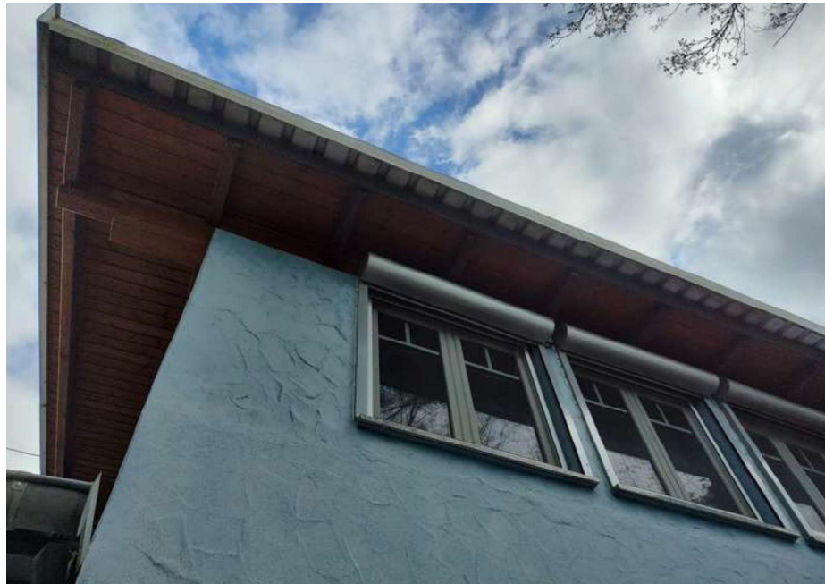
Abb. 6: Beim Bau des noch bewohnten Hauses in der Südspitze des Vorhabengebietes wurde der Ortgang von unten verkleidet. Beim Rückbau des Hauses sollte eine ökologische Baubegleitung anwesend sein. Eine genaue Begutachtung ist in situ nicht möglich.
