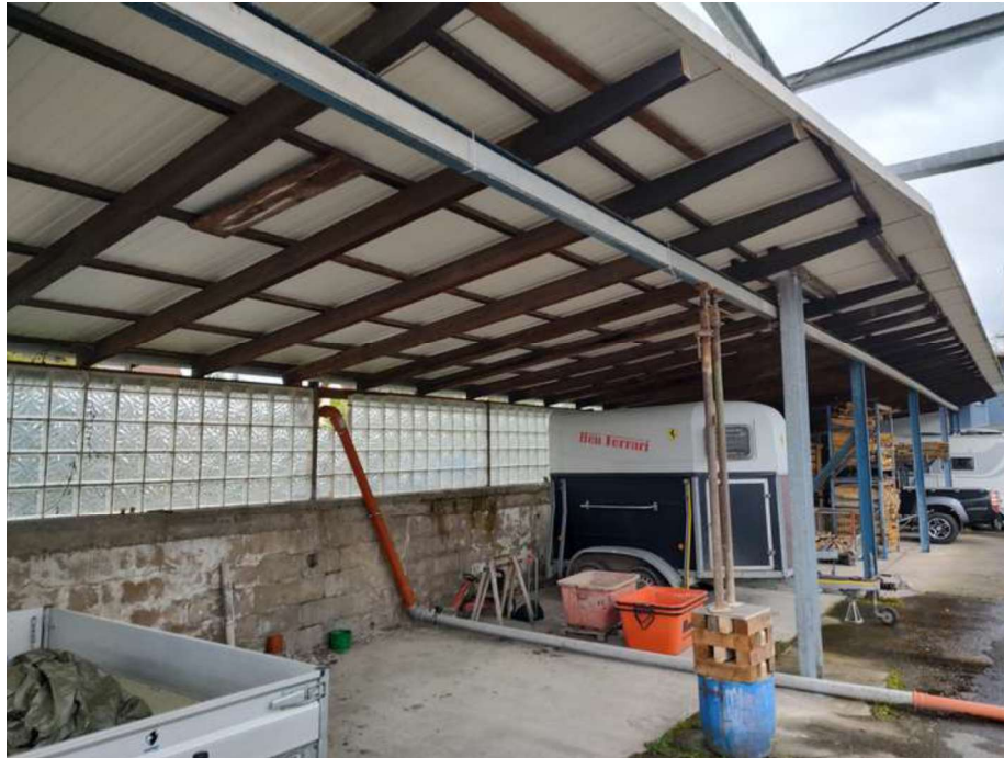
Abb. 4: Vollständig versiegeltes Plangebiet, Werkshalle im Zentrum des Bildes wurde bereits zurückgebaut.
