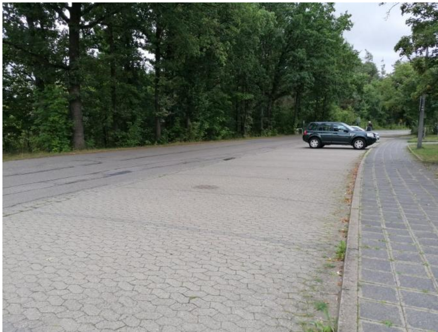
Abbildung 10 und 11: bestehende Rothauracher Straße, die zurückgebaut wird - randständige Eichen werden erhalten
