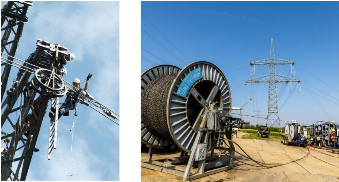
Abbildung 50: Leiterseillaufrolle während des Seilzugs (links) und Leiterseiltrommel für Kabelzug (rechts)
