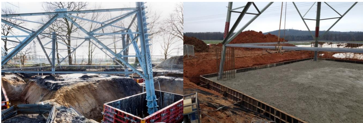
Abbildung 48: Herstellung Stufenfundament (links) und Herstellung Plattenfundament (rechts)
