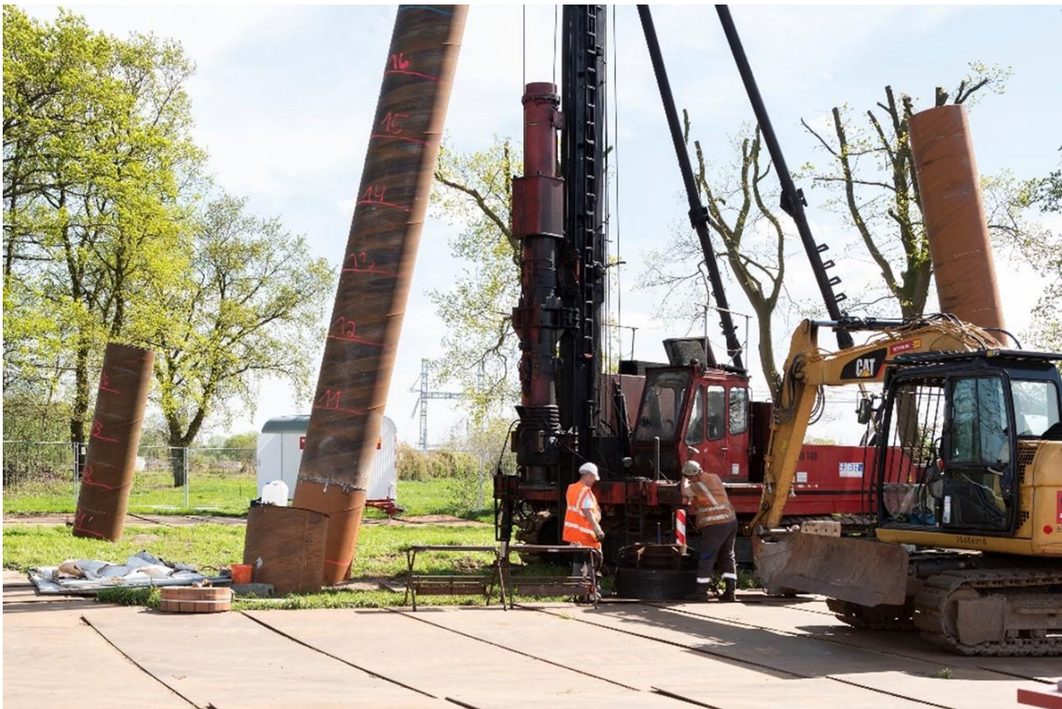
Abbildung 47: Herstellung Pfahlgründung
