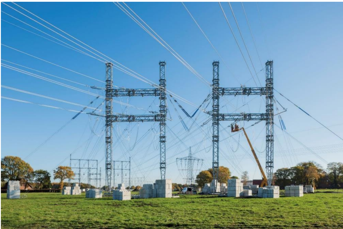
Abbildung 44: Freileitungsprovisorium für zwei 380 kV-Stromkreise
