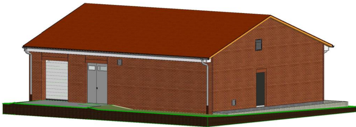
Abbildung 43: Betriebsgebäude KÜA Mühlhausen Süd mit Kompensation (Abm.: 13x16 m)
