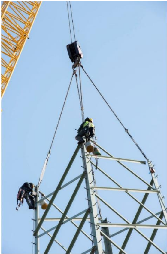
Abbildung 49: Mastmontage mittels Mobilkran
