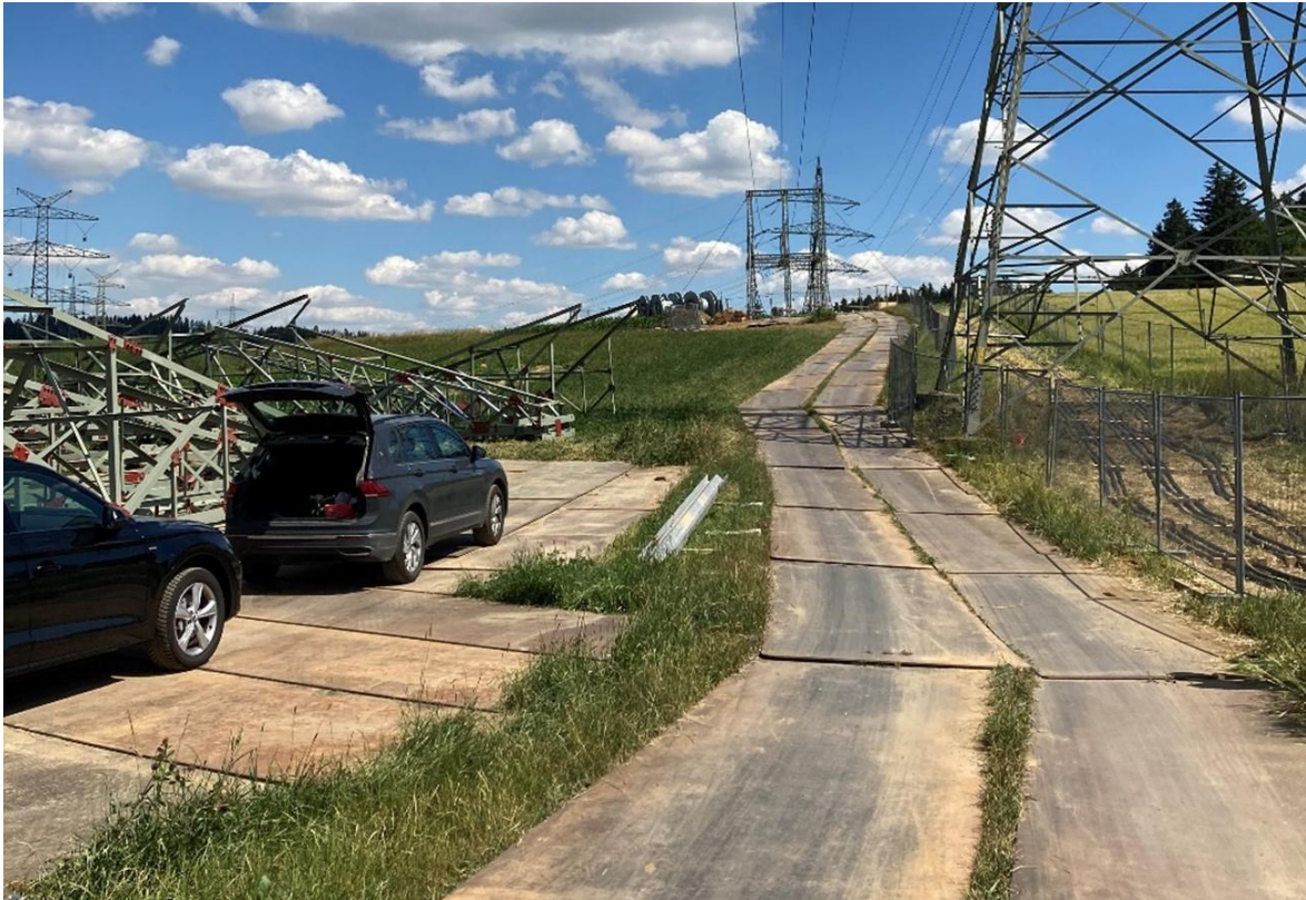
Abbildung 46: Beispiel für eine temporäre Mastzufahrt
