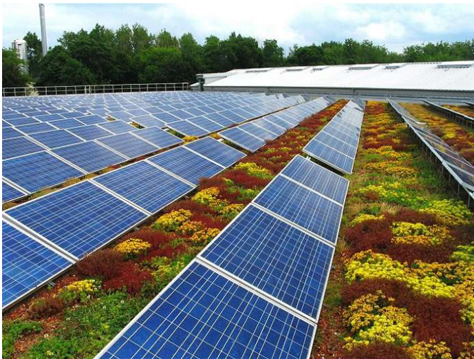
Beispiel: Dachbegrünung mit Photovoltaikanlage, Quelle: Stadt Dresden
