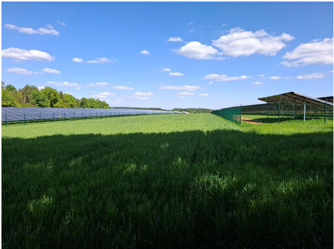
Blick von Westen über die geplante Anlagenfläche nach Osten; umgebend besteht der Solarpark Oberbürg 2
