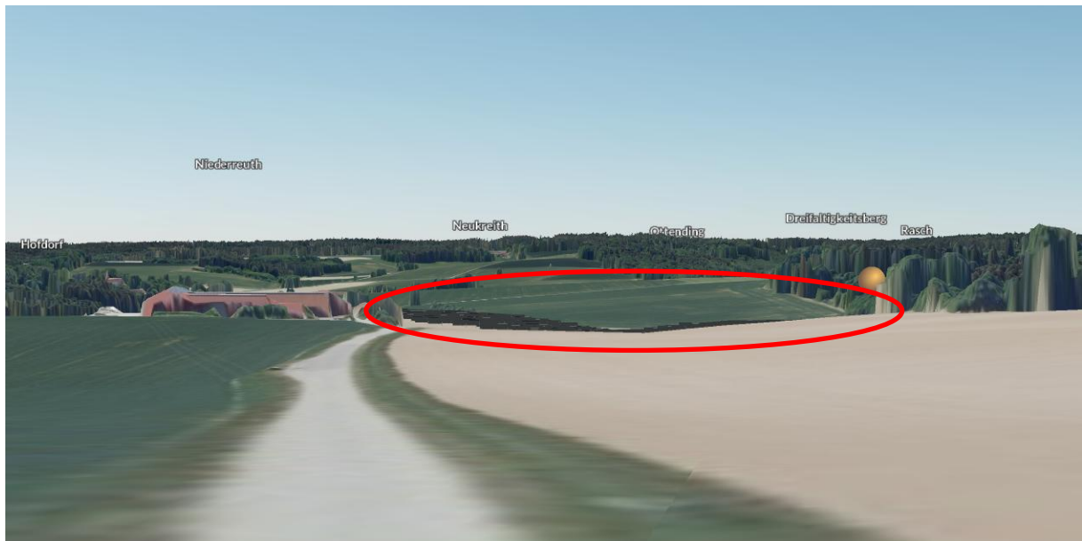
PV-anlage aus nördlicher Blickrichtung aus einer Entfernung von ca. 650 m betrachtet, PV-Module rot umrandet (Quelle: Energie-Atlas Bayern).
