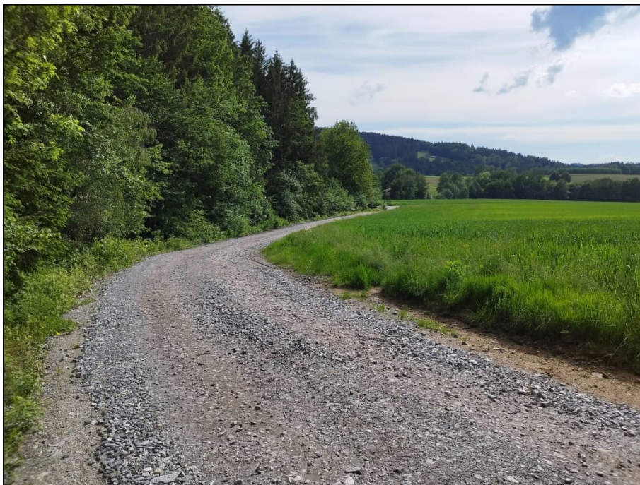
Blick von Norden nach Süden auf den Betriebsweg. Rechts das obere Feld.
