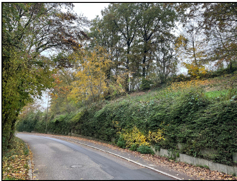
Gruber Straße mit Bepflanzung und Stützmauer im südlichen Bereich des Planungsgebietes; Blickrichtung Nordwesten
