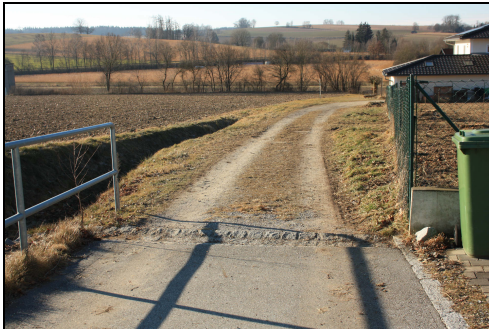
Blick von der Thalhamer Straße auf den Feldweg – Zufahrtbereich, mit Entwässerungsgraben
