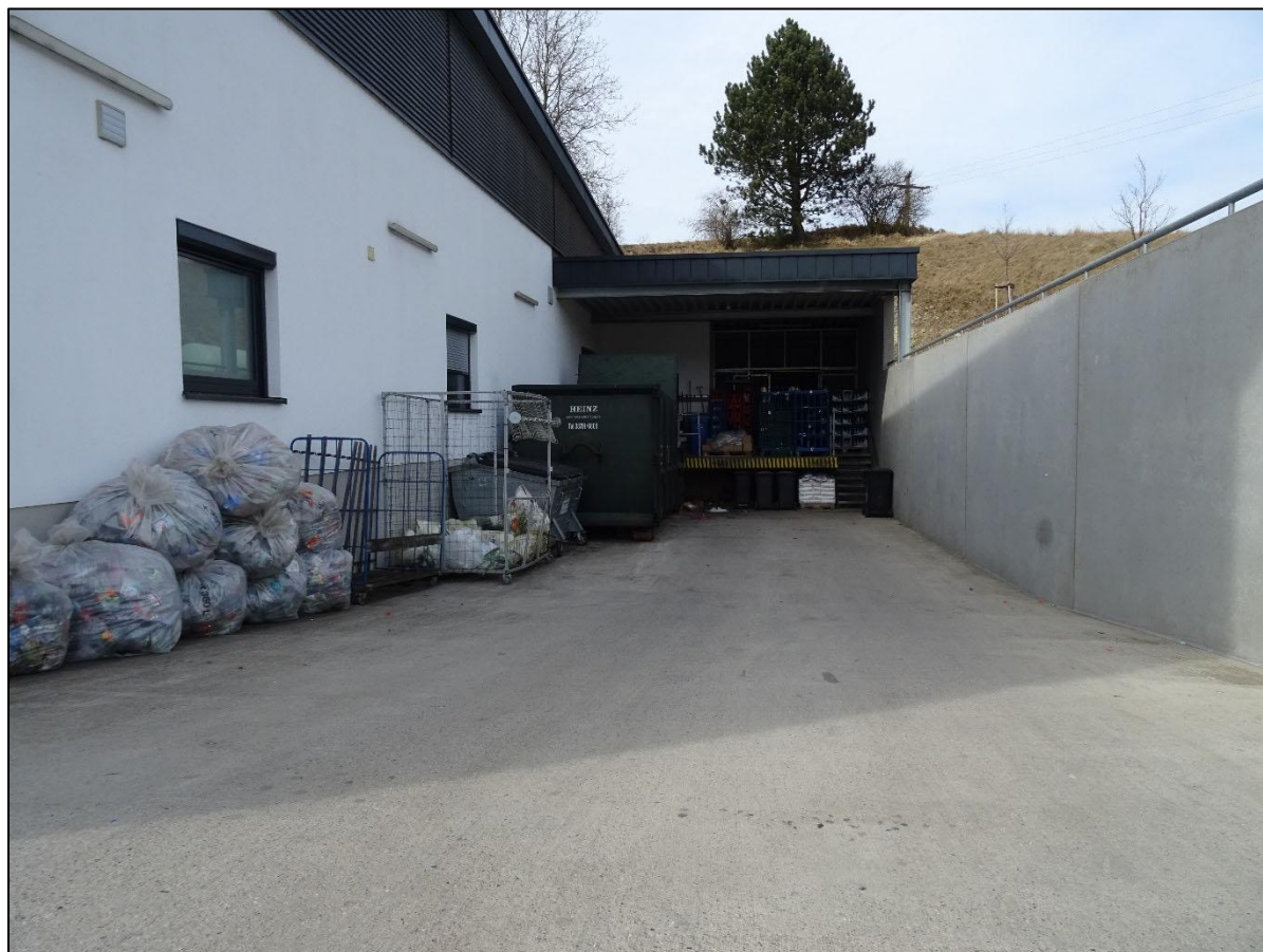
Abbildung 9 Blick nach Norden auf den Anlieferbereich an der Ostseite des EDEKA (b)
