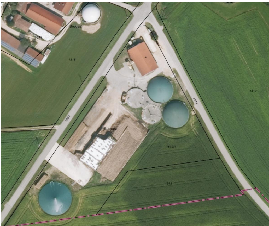
Biogasanlage Oberpettenbach (Luftbild Bayerische Vermessungsverwaltung)
