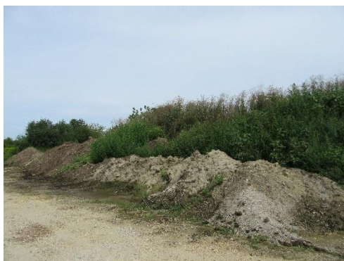
Lagerndes Aushubmaterial Ostseite FL1
