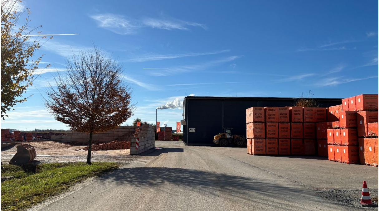
Abb. 6: Ansicht von Norden – Produktionshalle der Fa. RedBloc im Süden der Planungsfläche (Foto Oktober 2025 Jocham Kessler Kellhuber GmbH)
