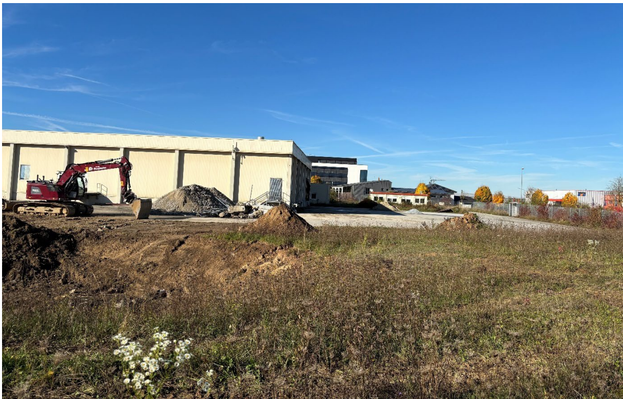
Abb. 3: ehemalige Produktionshalle der Firma Stanglmeier im Geltungsbereich des Planungsgebietes (Foto Oktober 2025 Jocham Kessler Kellhuber GmbH)
