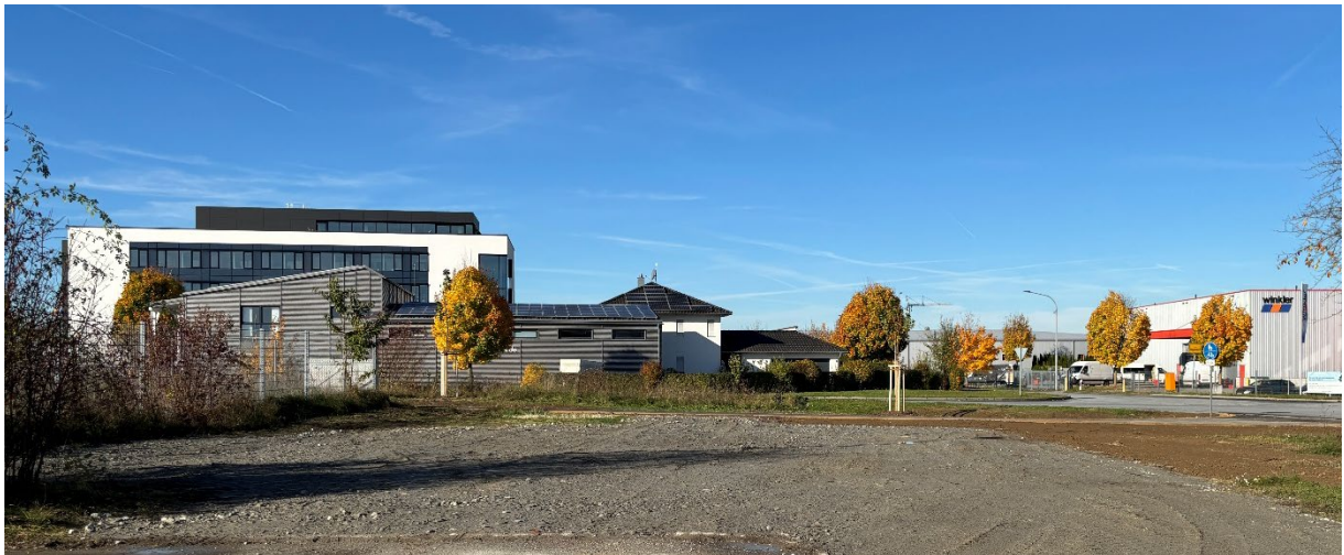
Abb. 7: Ansicht von Osten – Gewerbebauten auf der gegenüberliegenden Straßenseite im Westen der Planungsfläche (Foto Oktober 2025 Jocham Kessler Kellhuber GmbH)
