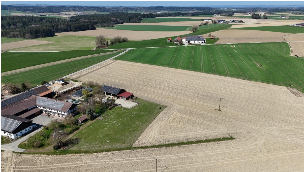
Abb. 6: Baufeld 4b - SO 4b, Blick von Südwesten auf die Flächen, Foto MaxSolar (April 2025)
