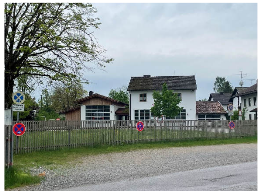
Bestehendes Feuerwehreal im Ortsteil Aying mit eingeschränkten Platzverhältnissen.
