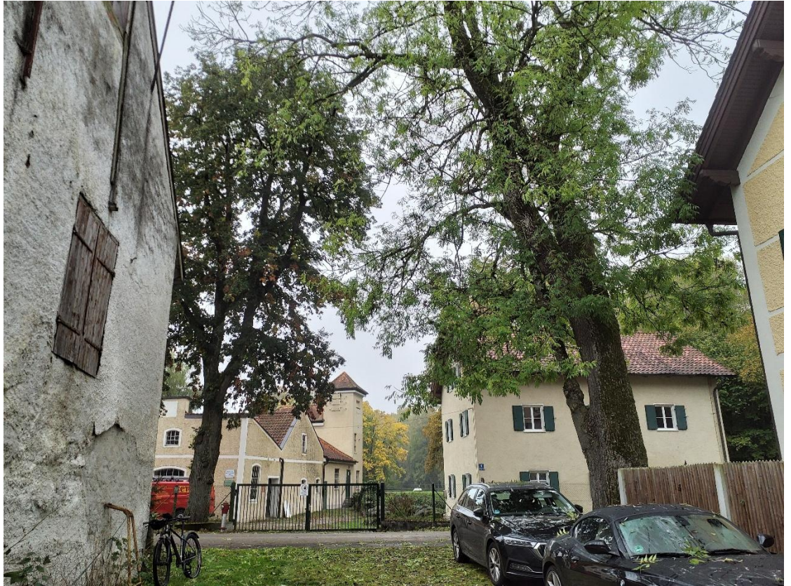
Abb.8: Bestandsgebäude nördlich des Geltungsbereiches, Aufnahme PV vom 10.10.2025
