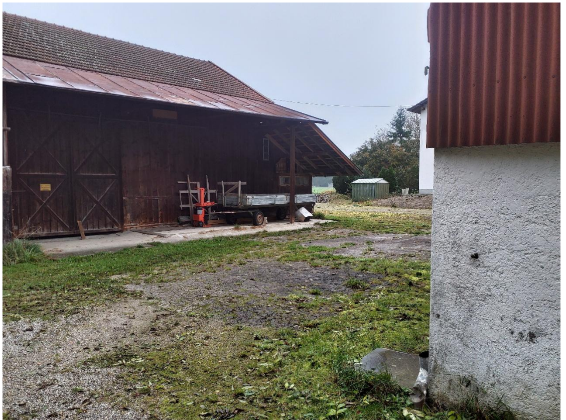
Abb.9: Bestandsgebäude nördlich des Geltungsbereiches, Aufnahme PV vom 10.10.2025
