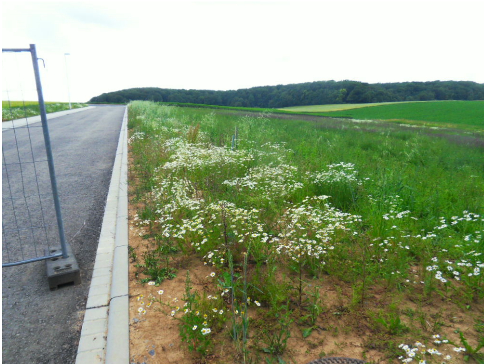
Blick nach Westen Richtung Waldgebiet Alter Berg
